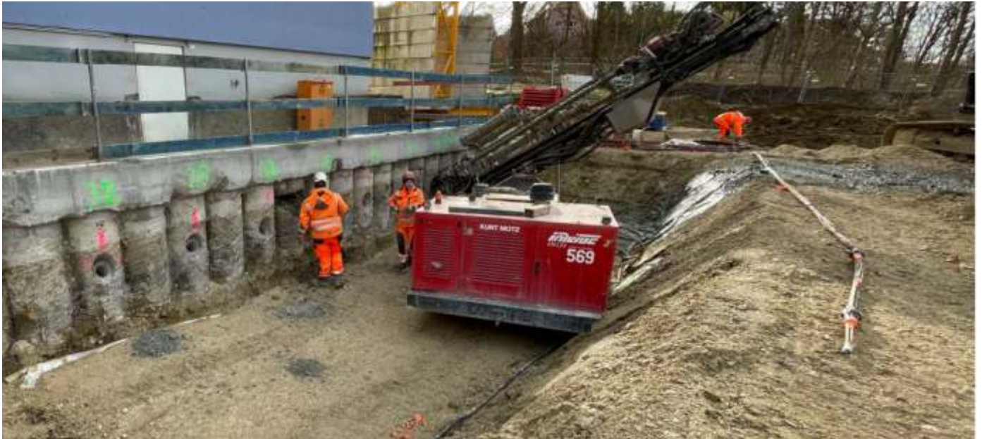
Die aufwendige Gründung mit Rückverankerung zum Schutz des Nachbarhauses
