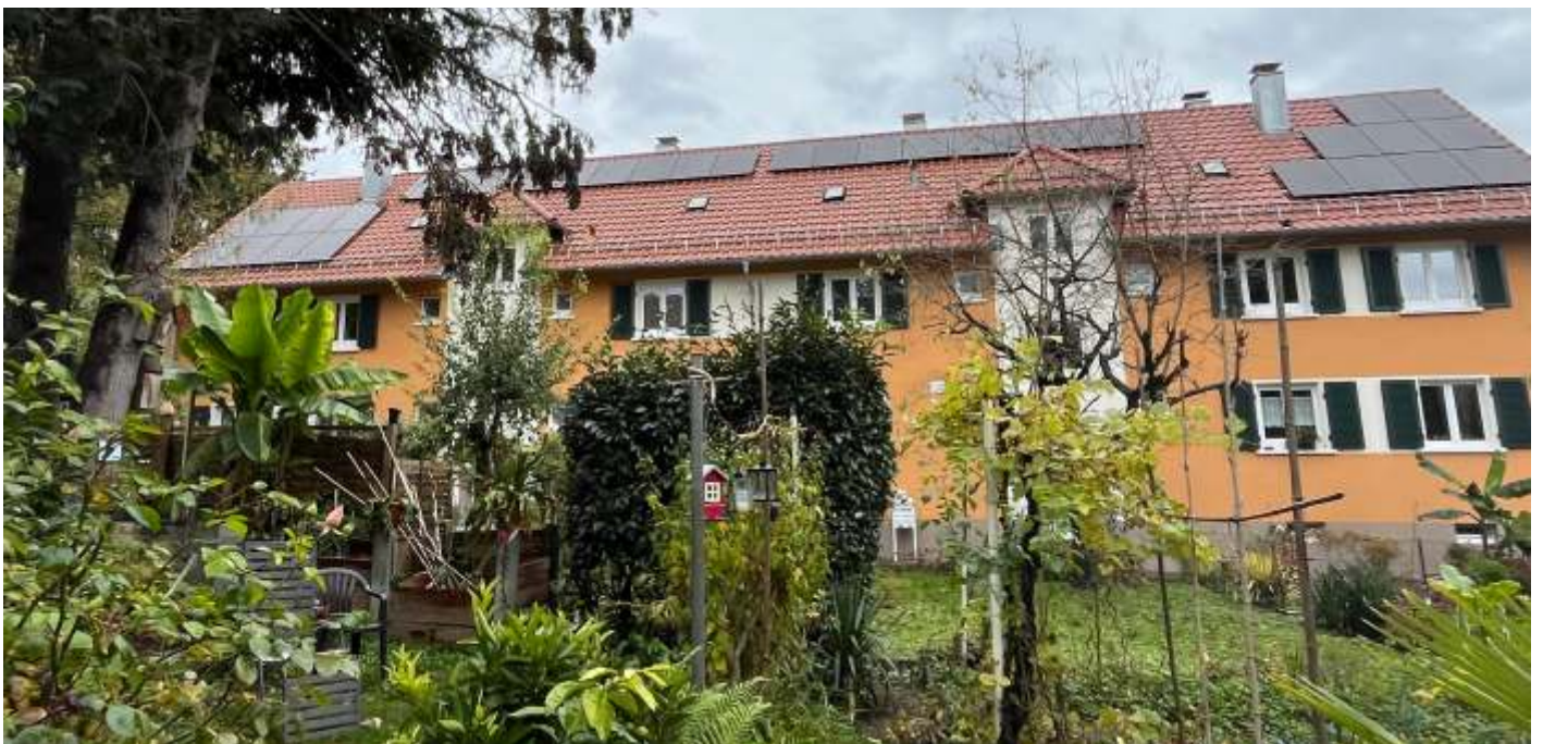
Photovoltaik in der Austraße 71/73
