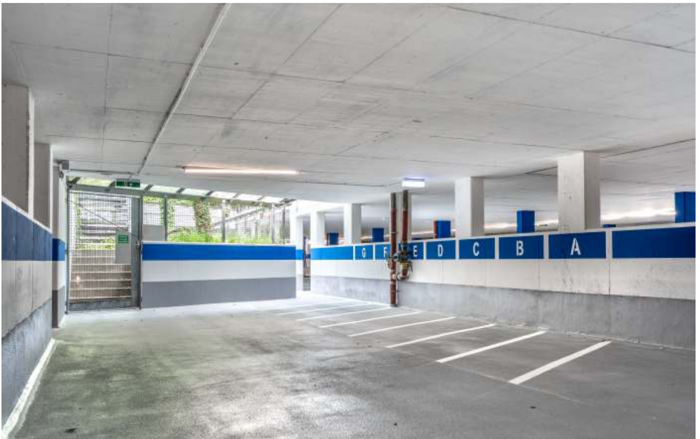
Tiefgarage nach der Sanierung
